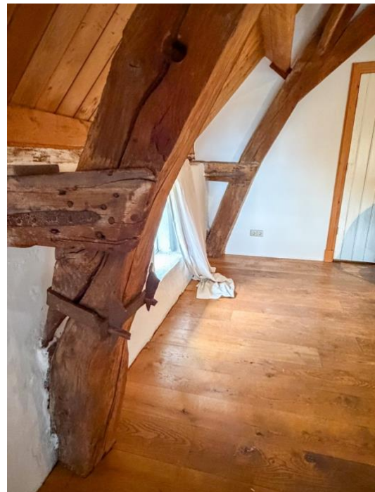
Twee krommers op de achterzolder van De Roos met linksonder het smeedwerk uit 1600.
