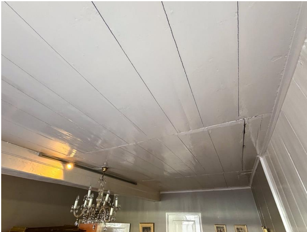
Plafond van geschaafde planken in het achterhuis. De Lodewijkskamer in kasteel heeft een vergelijkbaar plafond.
