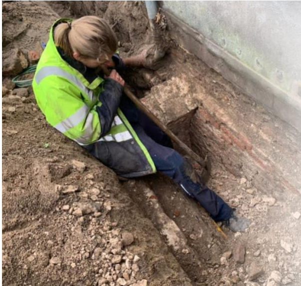
Opgraving aan voorzijde De Roos 2021. Afgekapte gewelf, dichtgemetseld met 18e-eeuwse stenen, buiten de huidige voorgevel. Links is de laatmiddeleeuwse fundering van de oorspronkelijke voorgevel zichtbaar.
