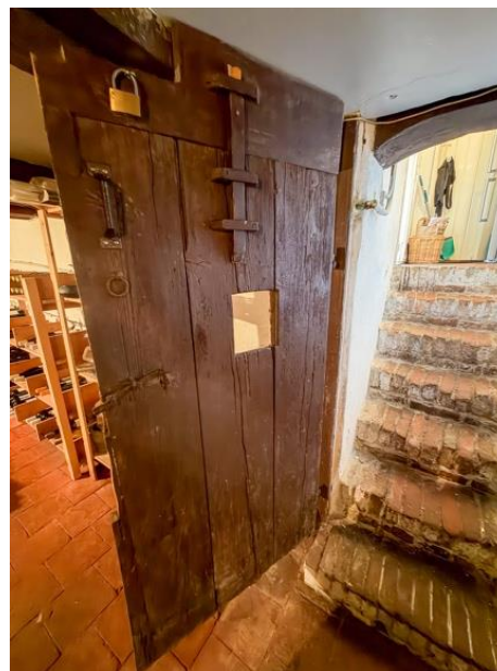
Gevangenisdeur met halverwege aan de linkerkant een slot aan de buitenkant en aan de bovenzijde een luik om eten en drinken door te kunnen geven.
